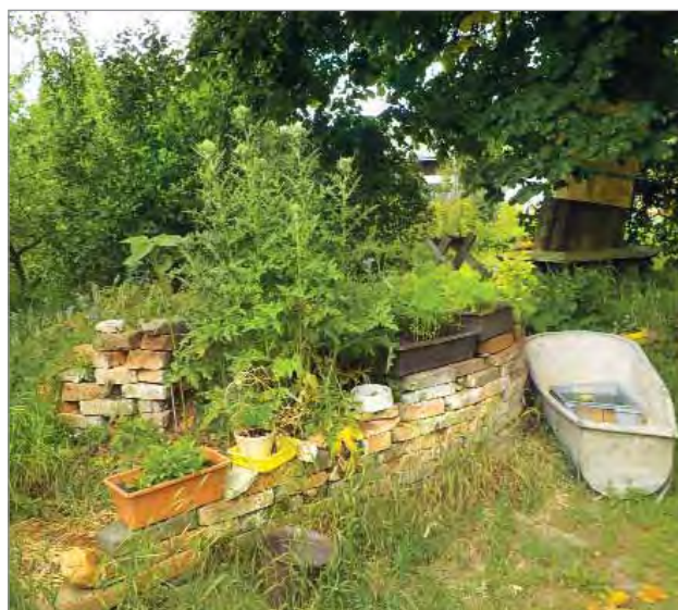
Odložené cihly slouží jako suchá zídka.
